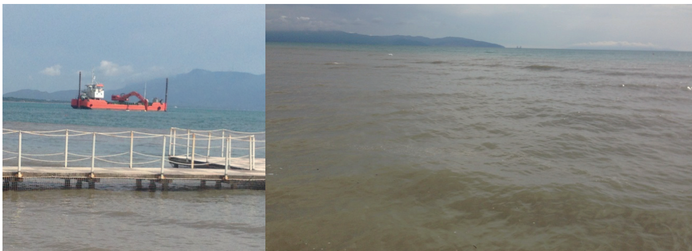
Particolari della draga (a sinistra) e del grande "Plume" di torbida generato durante il dragaggio (a destra)
