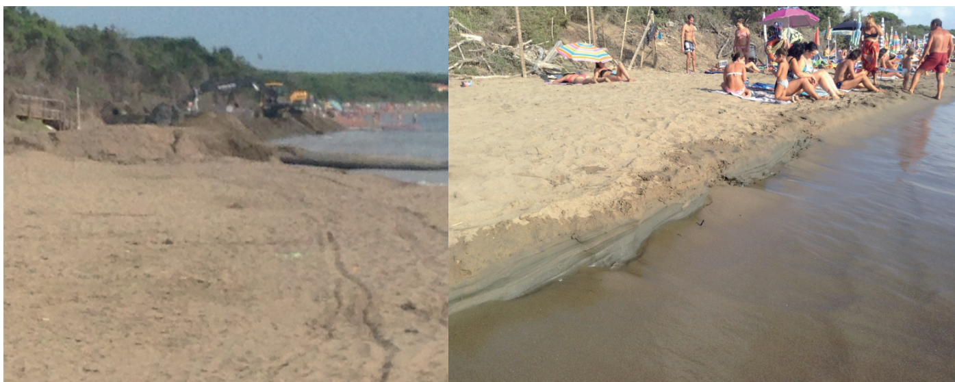
Sversamento dei sedimenti sulla spiaggia (sabbia ed altro di colore scuro) (foto a sinistra) e spiaggia dopo l'intervento situazione successiva ad una piccola mareggiata (scalino percepibile)
